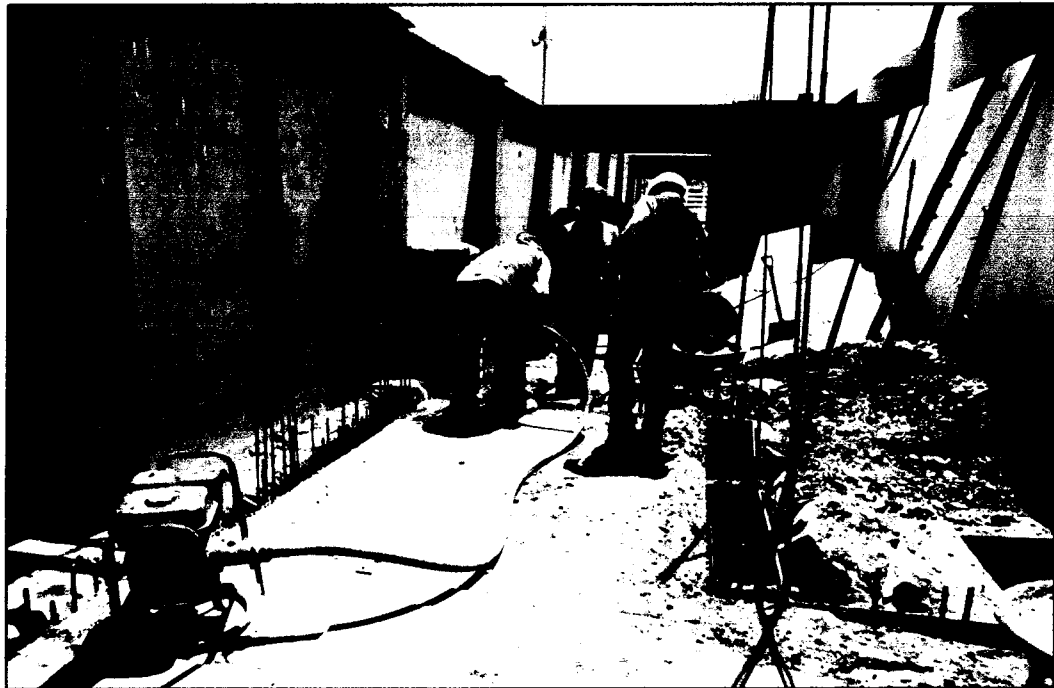
SE OBSERVA EL VIBRADO DEL CONCRETO DE LOS MUROS DE LA CISTERNA
