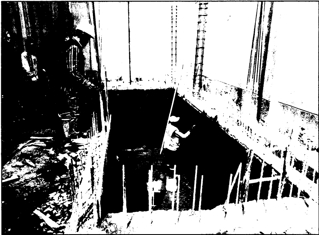
SE OBSERVA EL TARRAJEO DE LOS MUROS DE LA CISTERNA CON IMPERMEABILIZANTE
