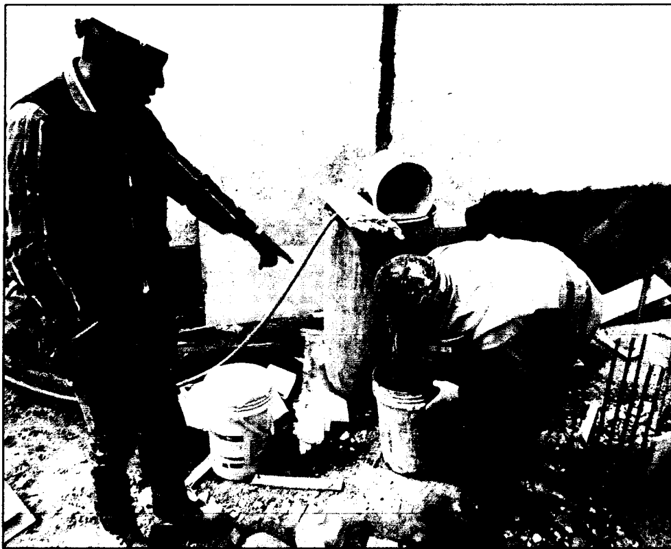
SE OBSERVA EL TARRAJEO DE LOS MUROS DE LA CISTERNA CON IMPERMEABILIZANTE
