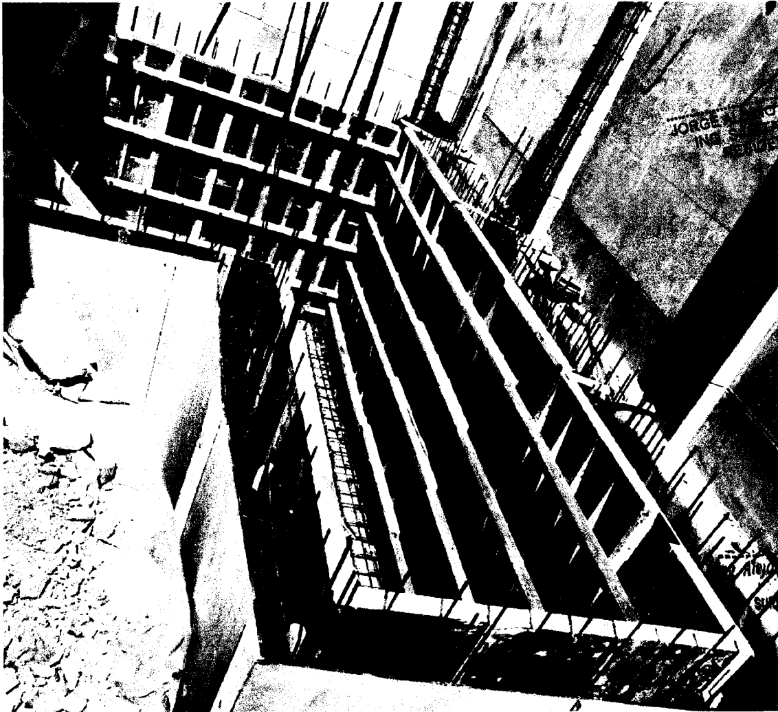
SE OBSERVA ENCOFRADO INTERIOR Y EXTERIO DE MUROS DE CISTERNA
